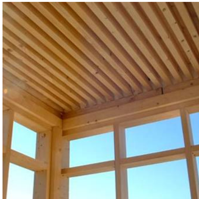
Figure 9 : Exemple type d'un plafond obtenu avec une dalle O'portune® en planches décalées ou avec une D-Dalle® bois-béton
