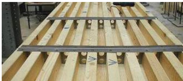
Figure 5 : Photo des connecteurs une fois fixés à la dalle
