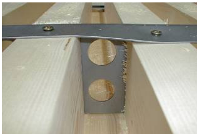
Figure 6 : Détail des percements dans le connecteur pour permettre d'enclaver le béton dans la dalle bois et réaliser ainsi une section composée 100 % efficace.
